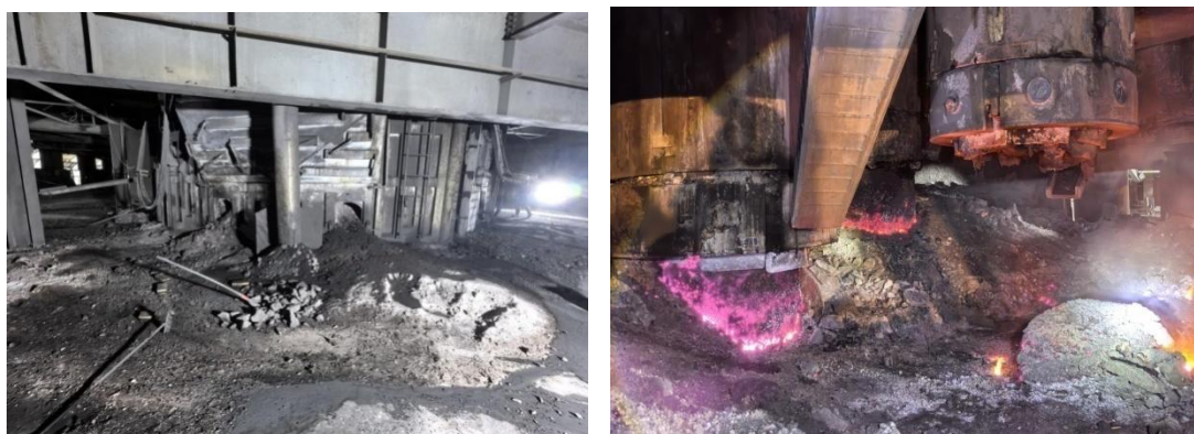
2#矿热炉炉外现场
