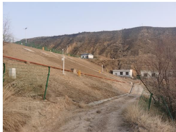
泵站前池区域拟更换溢流管现状
