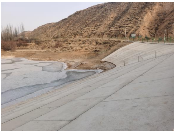
左坝肩拟帷幕灌浆区域现状
