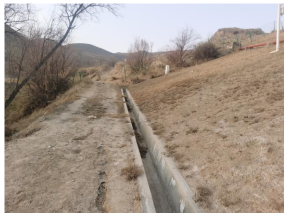
库区至坝下现有道路
