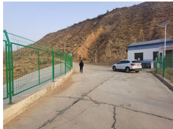
坝顶施工营地区域现状
