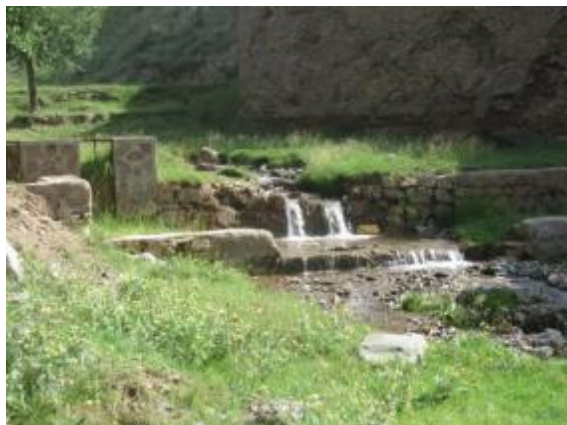
巴藏沟沿线农灌引水口现状
