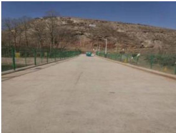
大坝坝顶道路及施工营地区域现状
