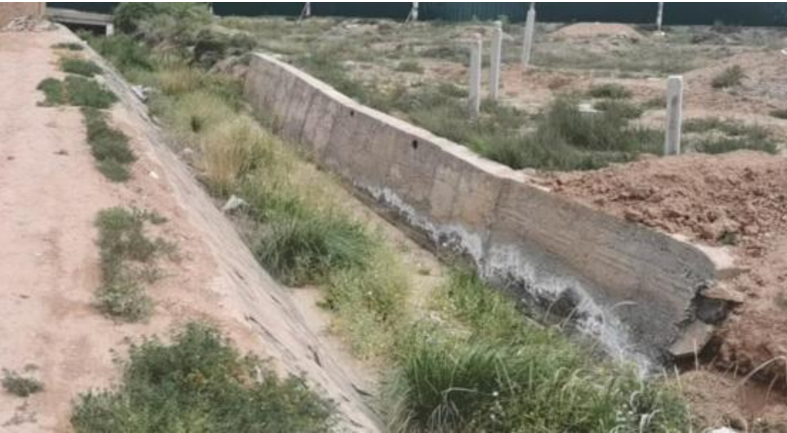
东街村沟道现状
