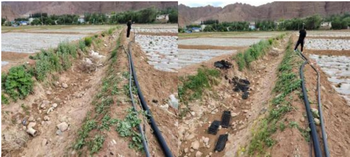
下滩村沟道现状
